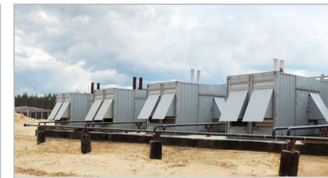
Блок-модули ДГУ 1000 кВт и 2000 кВт
