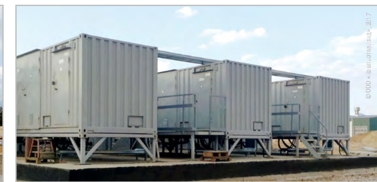
Блок-модули КТП 2500 кВа 0,4/10 кВ
