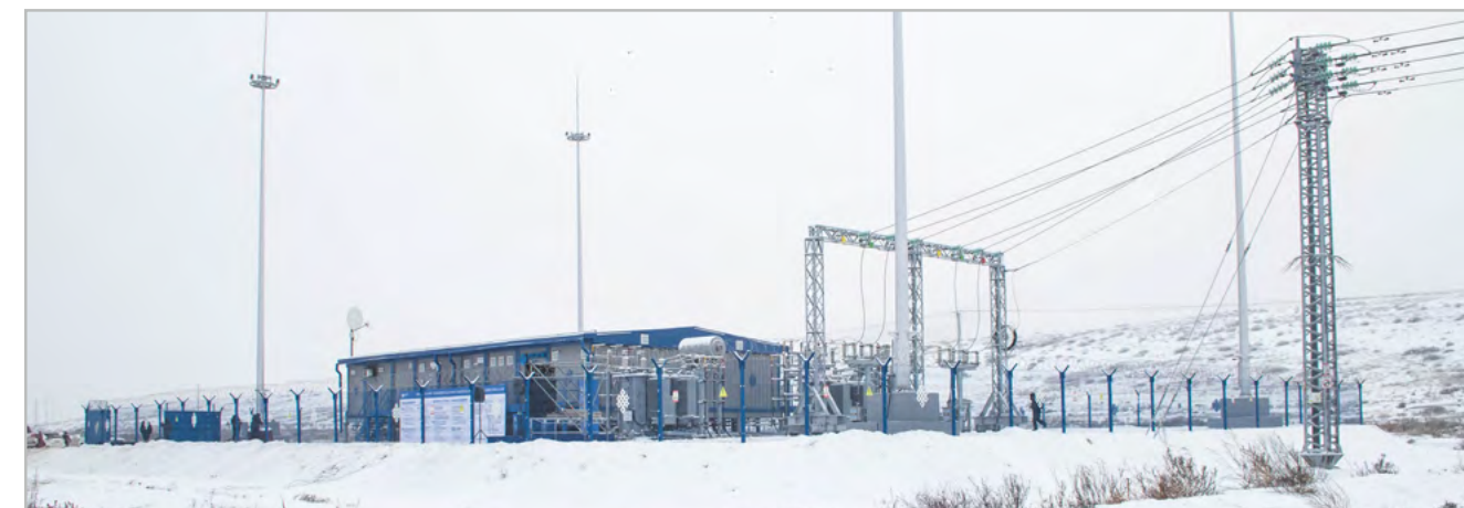
Модульная цифровая ПС 35/10 кВ
