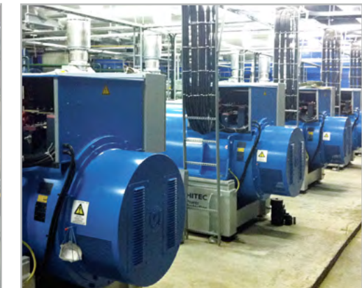
Комплекс установок Котельная
