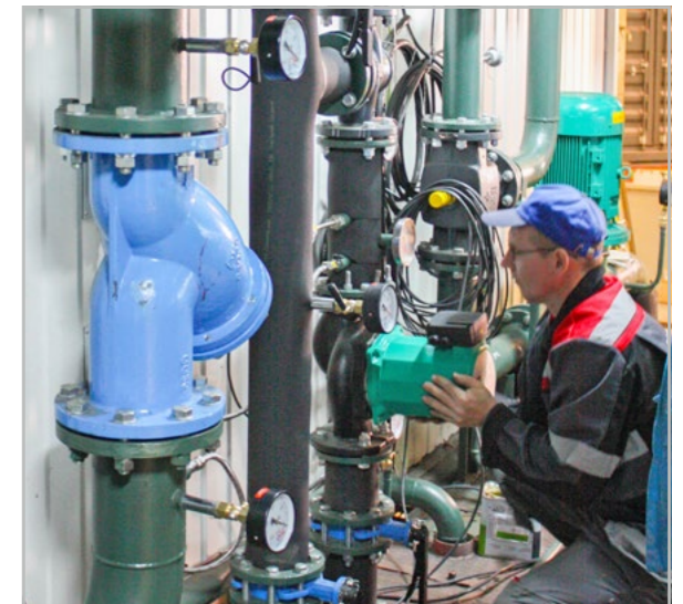
Монтаж насосного оборудования СУТ
