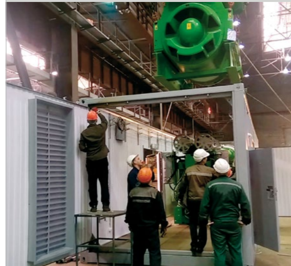
Пакетирование модуля ГПЭС 3350 кВт/4000 квА
