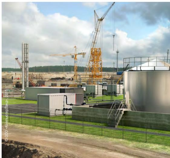
Котельная комплектуется из требуемого количества следующих функциональных модулей: блок-модуль с котлоагрегатом и блок-модуль со вспомогательным тепломеханическим оборудованием. Для установки в единичный модуль потребителю доступны котлоагрегаты, имеющие следующие значения мощности: 500 кВт, 1000 кВт, 1500 кВт и 2000 кВт.
